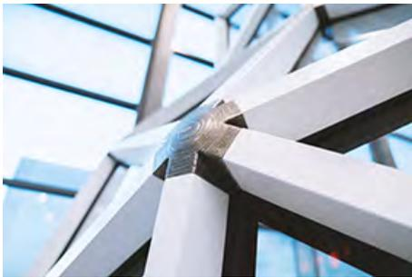
Die aufliegenden Dichtungsknoten werden passend zum Verbindungsknoten gedruckt, sodass die Entwässerung über nur eine Dichtungsebene erfolgt.
