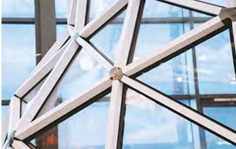
Die Freiformknoten aus Stahl oder Edelstahl werden für VISS<sup>3</sup> objektspezifisch hergestellt.
